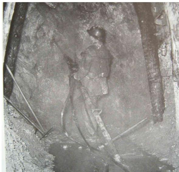
**Fig. 7** - Perforazione ad acqua con spinta fornita da servosostegno (Miniera di Niccioleta, 1956. Foto C. Banchi).
