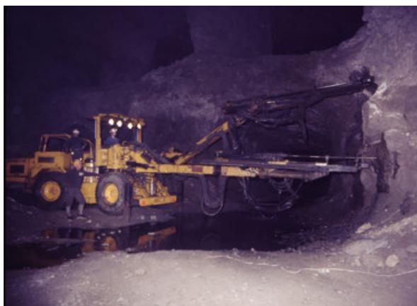
**Fig. 8** - Carro di perforazione elettroidraulico a due bracci con cabina aperta (Miniera di Niccioleta. Anni '70).
