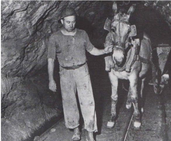
**Fig. 14** - Trasporto con vagoni a trazione animale (Miniera di Niccolita 1946. Foto C. Banchi).
