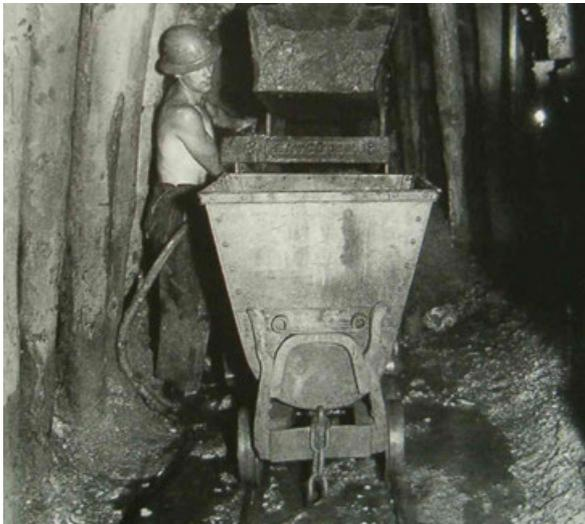
**Fig. 15** - Caricamento di un vagone con pala meccanica ad aria compressa dotata di benna da 0,14-0,60 m<sup>3</sup> semovente su binario con potenza di kW 6,5-17,5 (Miniera di Gavorrano. Anni '50).
