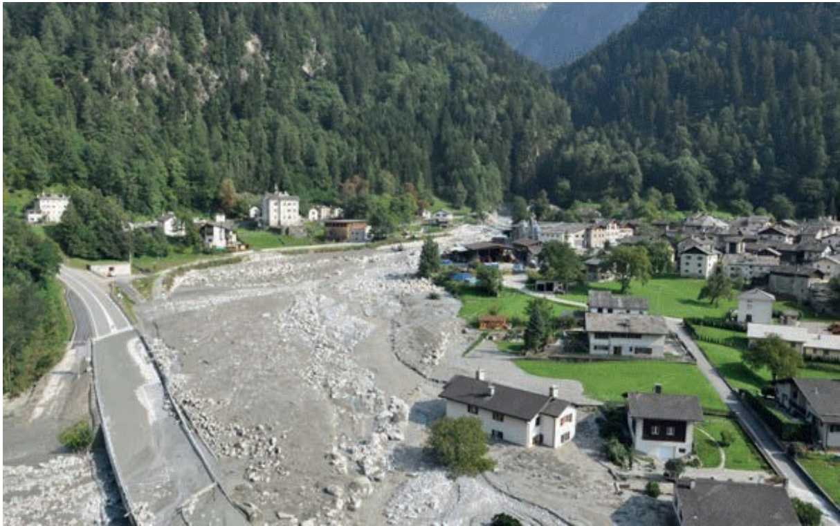
Fig. 8 - L'immagine mostra la tracimazione del "bacino di ritenzione" (31 agosto 2017) costruito nei pressi del paese di Bondo. Pur risultando insufficiente ad accogliere l'apporto di materiale, esso limitò i danni sull'abitato..
